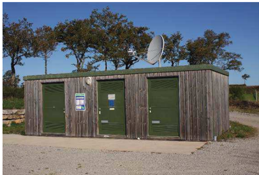
Figure 57 : Bardage bois et peinture vert foncé (source : ABIES)
